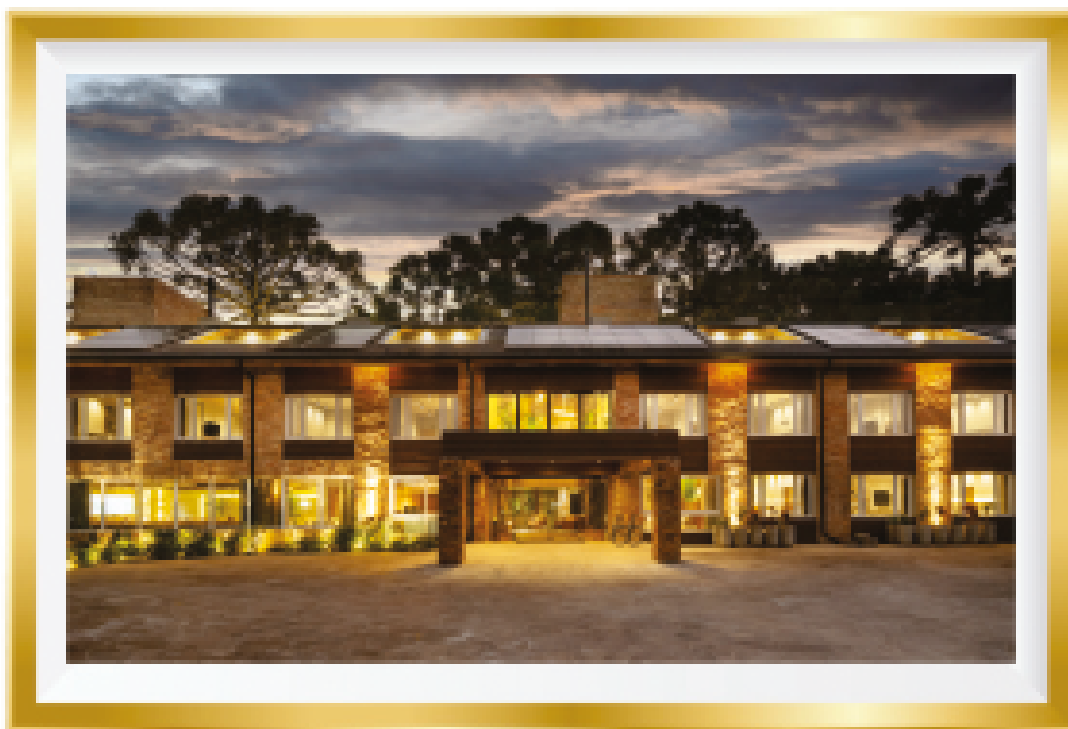
Fachada do Jangal das Araucárias
